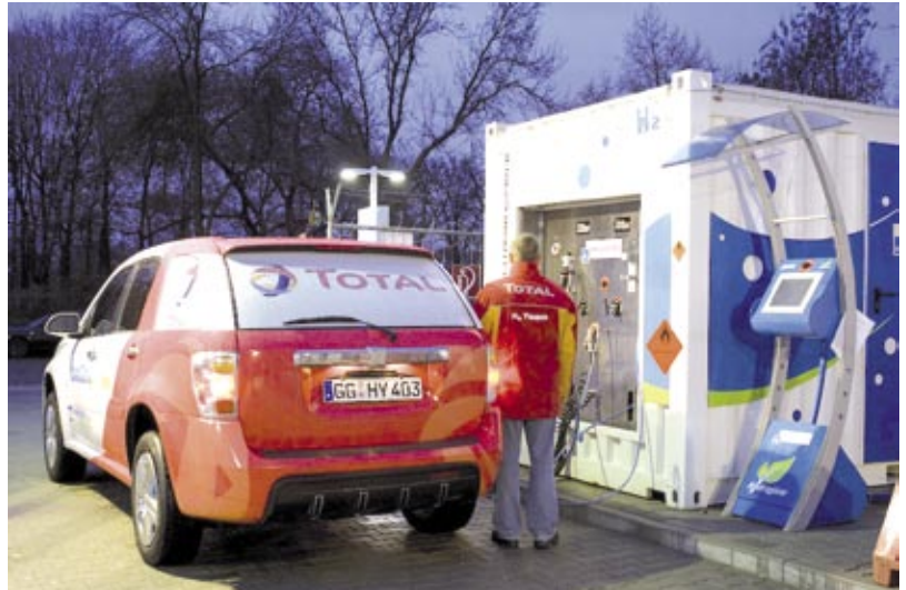
Übergangslösung: Diese semimobile Tankstelle eignet sich als Energiespender bis eine stationäre Anlage fertiggestellt ist.
