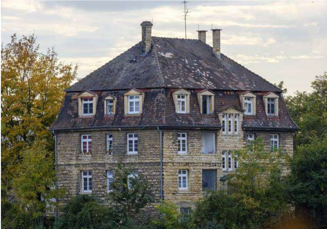
Die alte Fabrikantenvilla ist heute ein Arbeiterwohnheim.
