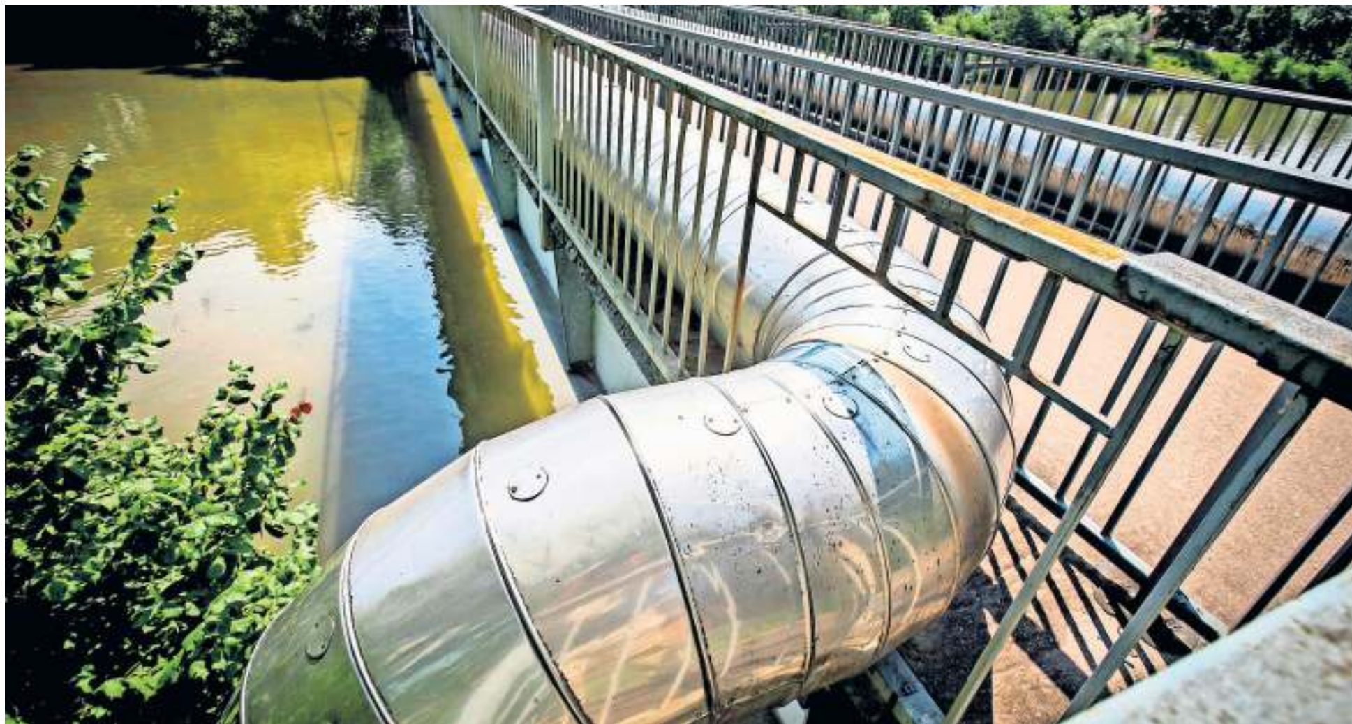
Es kann Jahre dauern, bis der juristische Streit um das Stuttgarter Fernwärmenetz entschieden ist.
